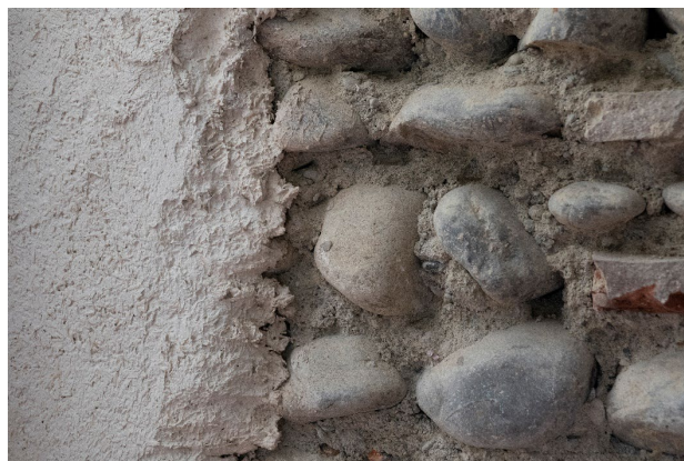
— Valorisation des galets de l'Adour et l'Echez des murs d'origine
