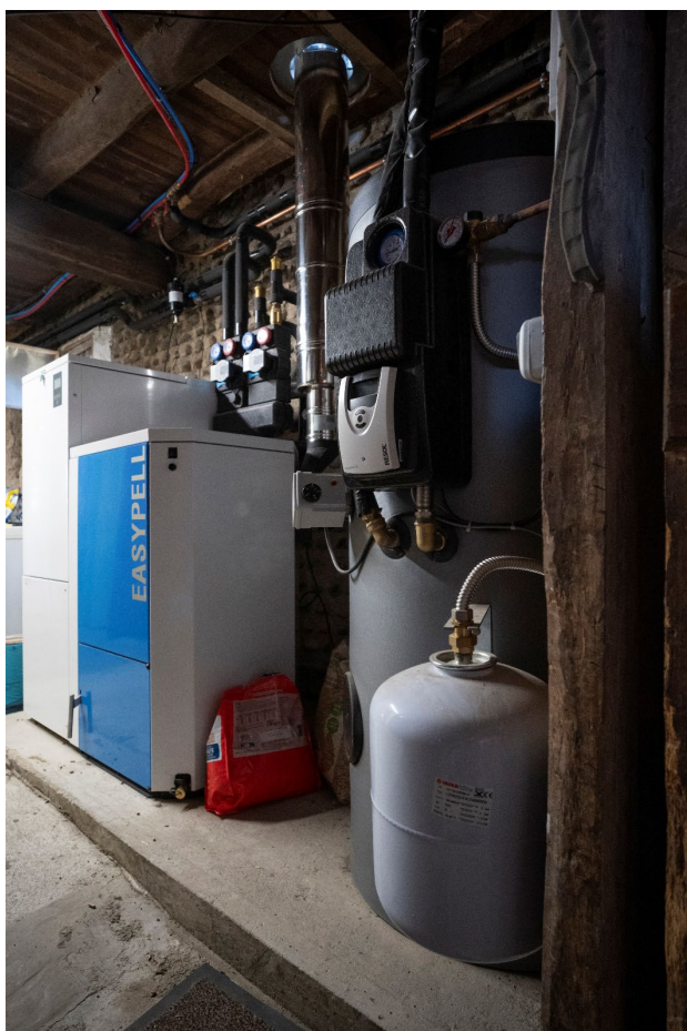
— Chaudière à granulés adaptée pour le solaire thermique
