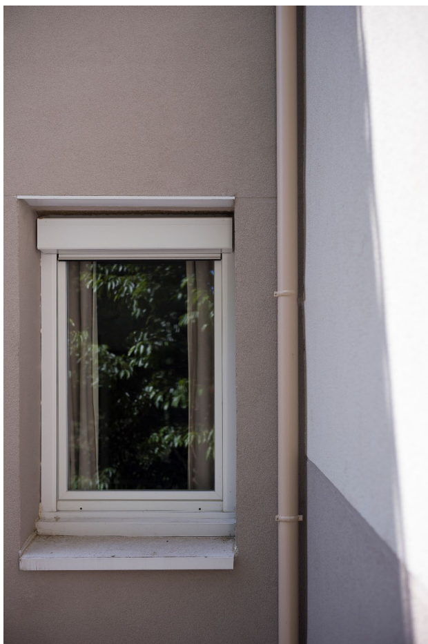
— Intégration des menuiseries avec l'ITE
