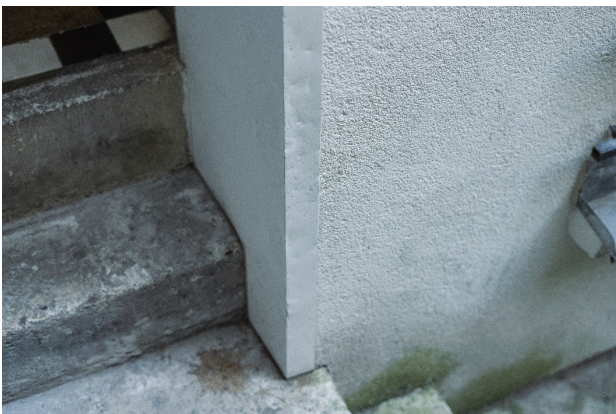
— Intégration de l'ITE vis-à-vis de l'escalier existant
