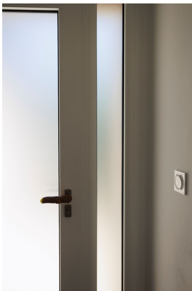
— Porte d'entrée laissant passer la lumière naturelle
