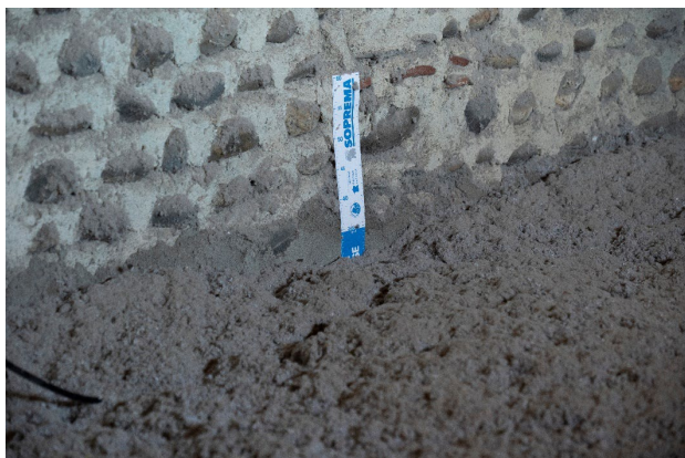
— Pige de contrôle de l'épaisseur de l'isolant soufflé
