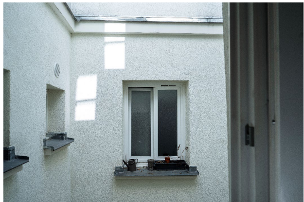
— Isolation par l'extérieur sur cour et bouche d'extraction d'air
