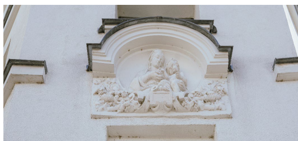
— Haut relief restauré sur isolation thermique par l'extérieur
