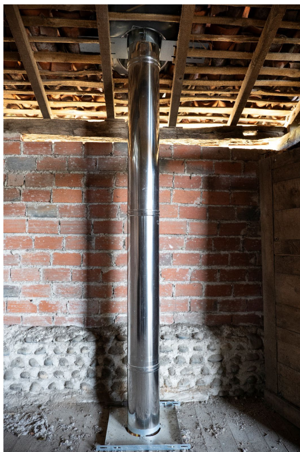
— Fumisterie traversant le plancher haut et la toiture
