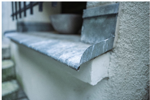
— Traitement entre l'ITE et une menuiserie
