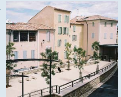
Exemple d'un projet achevé - Forcalquier, Alpes-de-Haute-Provence
