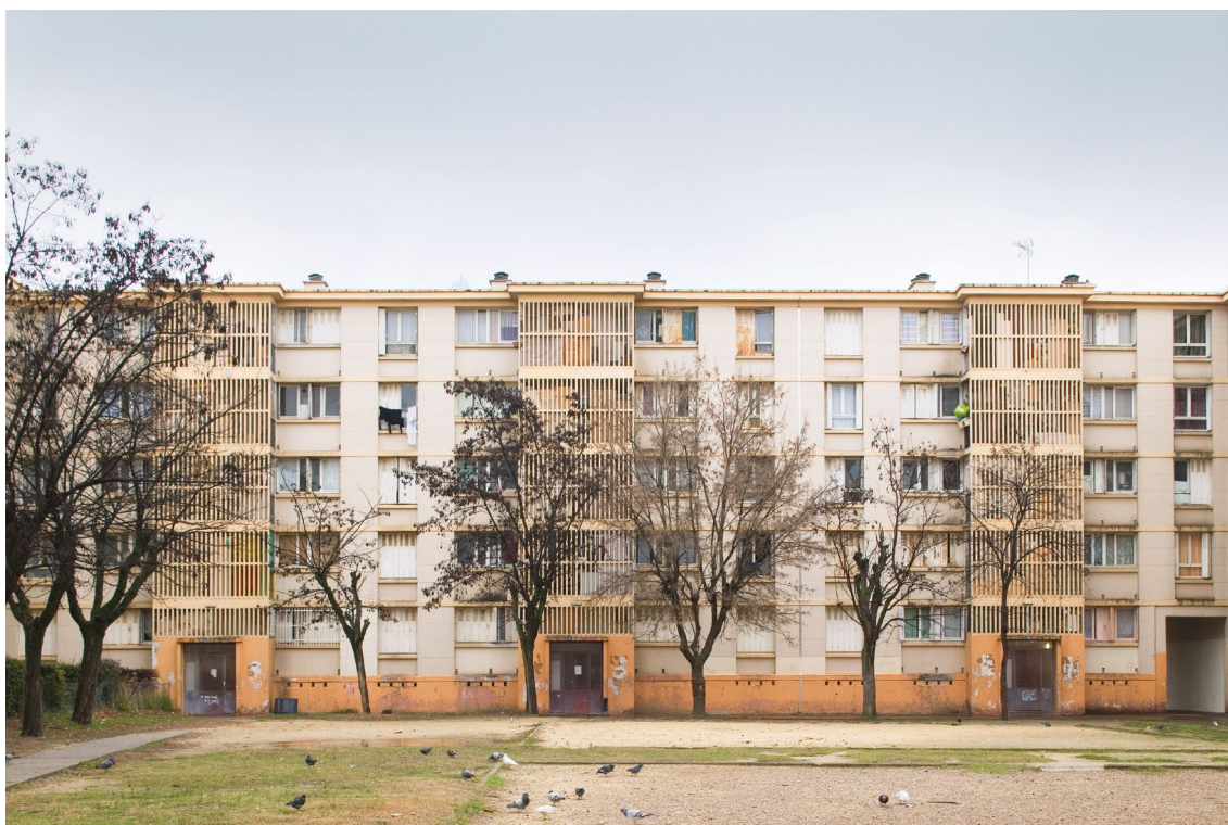
La copropriété du Petit Bard à Montpellier : états des lieux en 2009 avant le début de l'opération de réhabilitation. Source : Anah/Éric Sempé
