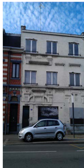
Opération à Roubaix (59) - façade externe Crédits photos : SOLIHA Métropole Nord
