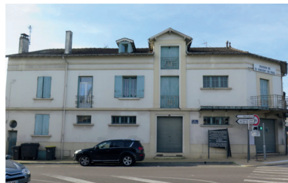
Le centre d'hébergement et de réinsertion sociale
